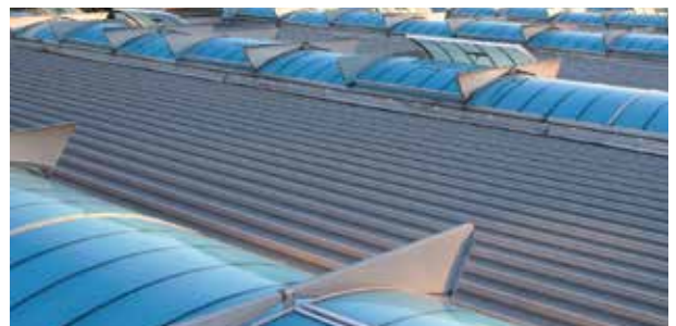
Gebogen lichtstraat met dubbele RWA-kleppen en winddeflectoren
